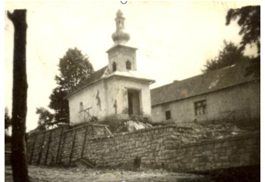
Stará nevšovská kaple postavená v roce 1888 a zbourána v roce 1949. Na jejím místě se začala stavět v roce 1950 nová, prostornější.
