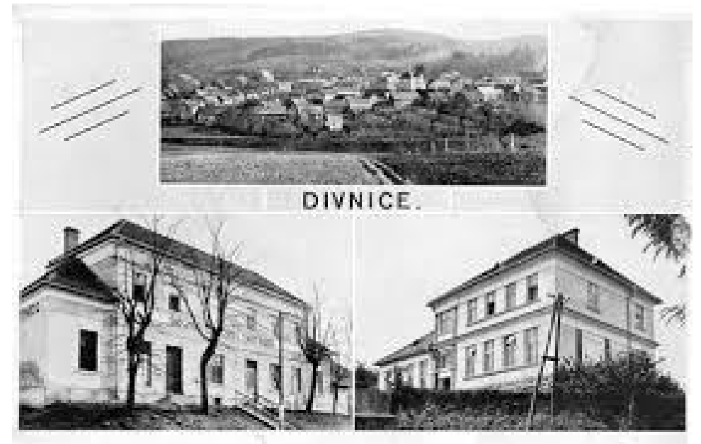
Vlevo škola v Divnici, současný Obecní úřad
